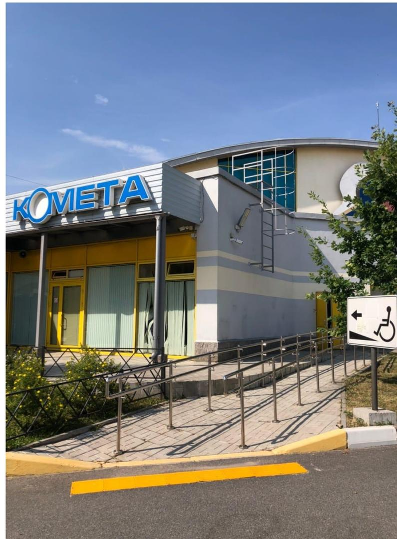
Вход (входы) в здание: ДП-В — доступно полностью всем. Входная площадка выполнена в соответствии с нормативными значениями, имеет твердое покрытие, не допускающее скольжения при намокании, над площадкой имеется навес, в темное время суток площадка освещена. Перед входом дополнительно выложена полоса текстурной контрастной плиткой, на прозрачных полотнах входных дверей имеется контрастная маркировка. Ширина входной двери в свету 1,45 м. Высота каждого элемента порогов отсутствует.
